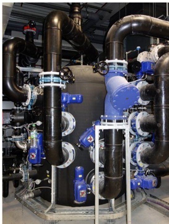
Jedna zo štyroch ZORTSTRÖM centrál uvedená do prevádzky, voda sa oddeľuje v 4 tepelných vrstvách
