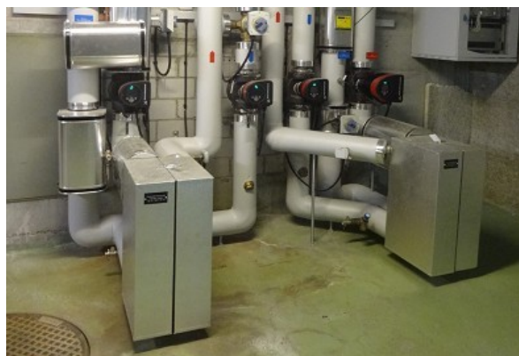
Odovzdávacia stanica diaľkového kúrenia
