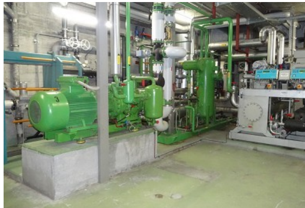
Chladiaca jednotka s využitím odpadového tepla
