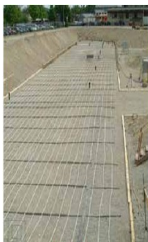
Zemné kolektory pod základovou doskou pre odobratie a regeneráciu tepla
