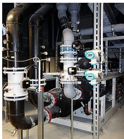
Tepelné čerpadlá s reverzným chodom pre kúrenie/chladenie každé cca 1430kW
