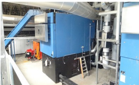
Kotol na drewnú štiepku 1.6 MW výkonu
