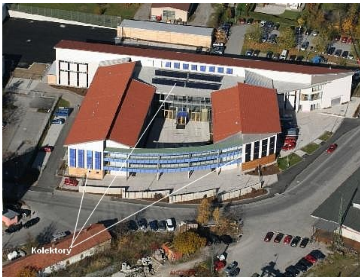
Umiestnenie slnečných kolektorov na fasáde a streche budovy, celková plocha 450m 2
