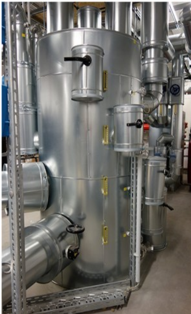
4-stupňová ZORTSTRÖM centrála pre kúrenie v budove správy objektov, priemer 900 mm (4 teplotné vrstvy 70°C, 55°C, 45°C a 33°C)
