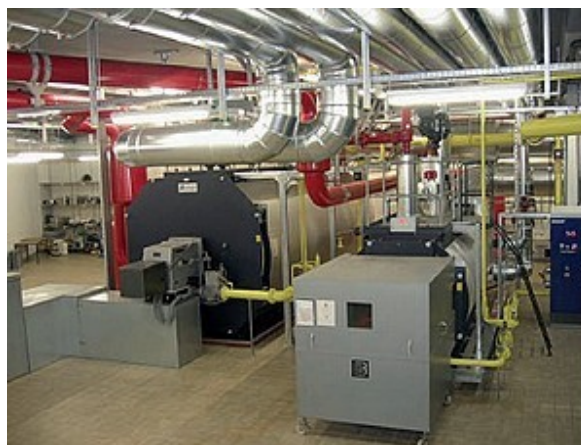
Kotolňa zásobujúca teplom jednotlivé haly cez diaľkové rozvody s celkovým výkonom 42 MW
