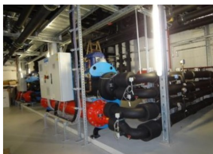
4 stupňová ZORTSTRÖM centrála v zdroji chladu – pred vyhotovením izolácie
