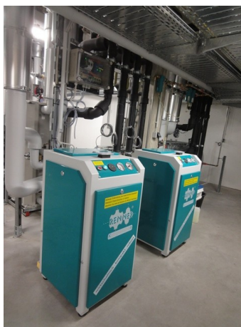
Reverzibilné tepelné čerpadlá pre kúrenie-chladenie
