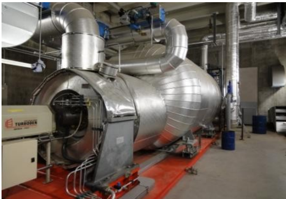
3 stupňový Zortström priemer 1800mm výška 2200mm, 9 systémových okruhov DN80 -DN300, obsah 5160 l, celkový výkon 11MW
