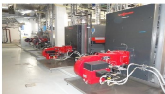
Inštalácia 4 kotlov v centrálnom zdroji tepla s celkovým výkonom 3.2 MW
