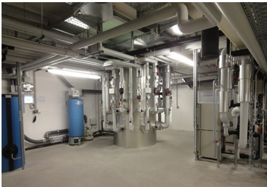
Umiestnenie ZORTSTRÖM centrály v strojovni tzv. stĺpová montáž montáž na podlahu
