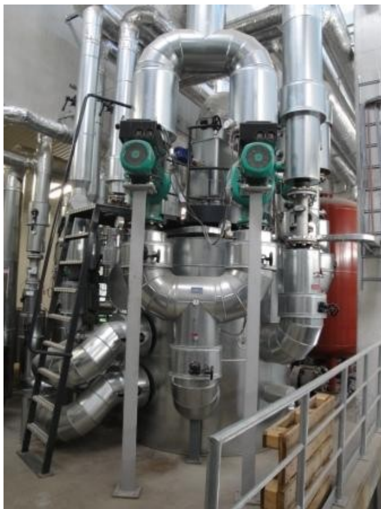
3 stupňový Zortström priemer 1800mm výška 2200mm, 9 systémových okruhov DN80 -DN300, obsah 5160 l, celkový výkon 11MW
