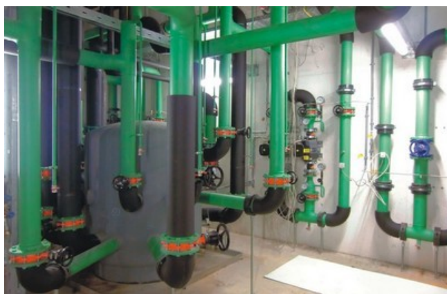
4 stupňová ZORTSTRÖM centrála v zdroji chladu – pred vyhotovením izolácie
