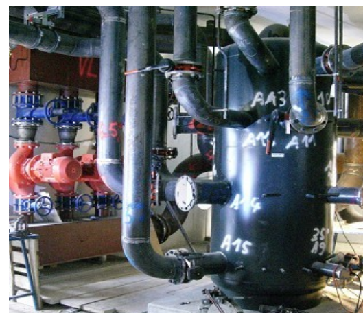
ZORTSTRÖM centrála pre chladenie 6/10/12/16/19°C Fotografia zachytila prebiehajúcu montáž
