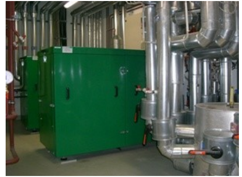
2 kogeneračné jednotky á 38kW
