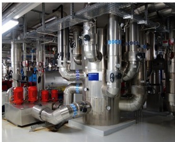
4 vrstvová Centrála ZORTSTRÖM pre kúrenie tepelné spády 75/52/45/35°C
