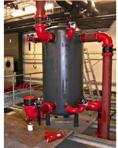
Kreissparkasse Köln - 3 stupňová centrála s akumuláčnou vrstvou pre chladenie počas montáže
