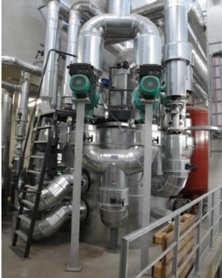
3 stupňový ZORTSTRÖM priemer 1800 mm výška 2200 mm obsah 5160 litrov, výkon 11 MW
