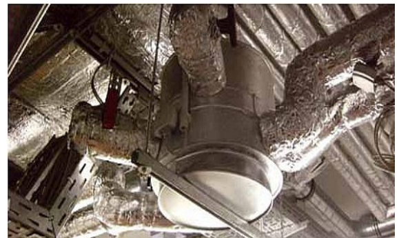
Klinikum Rheine stropná montáž
