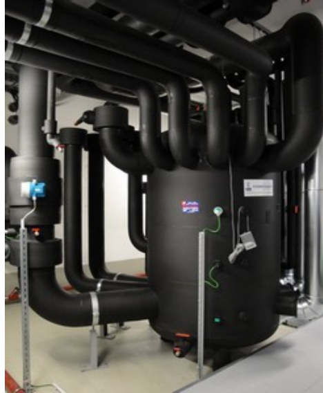
Astra Mníchov 4 stupňová centrála s akumuláčnou vrstvou - chladenie so spodnými vodami zo 150 m hĺbky
