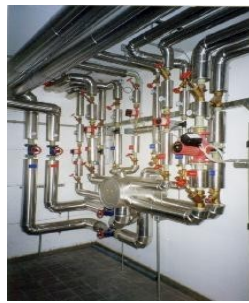
Linz diaľkové kúrenie montáž do rohu
