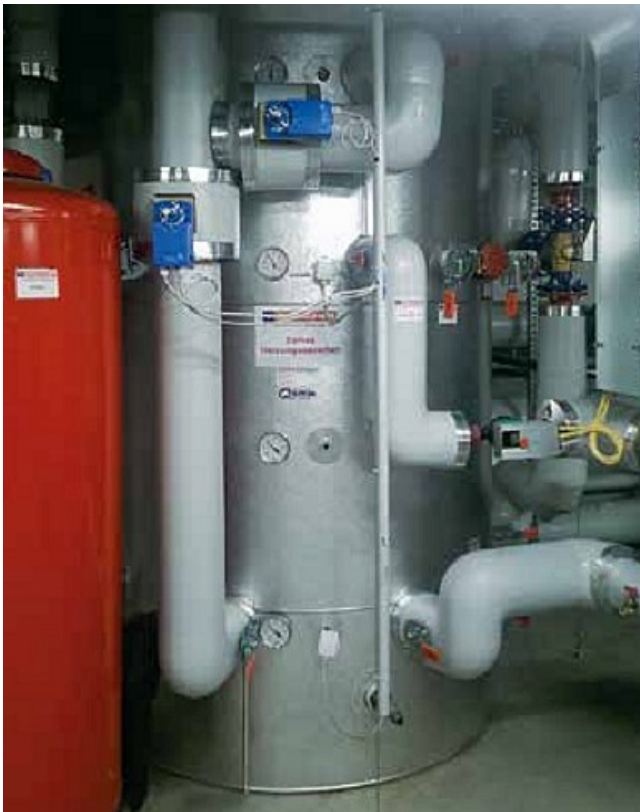
Zortström Multi-PG-H 5 vrstvový pre vykurovanie Priemer 1300 mm, výška 3310 mm, obsah 4111 l
