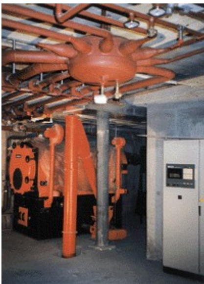
Prebiehajúca montáž, centrála ešte bez izolácie
