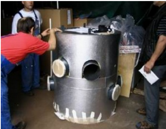
Inštalácia centrály nad kotlami, výkon centrály 6720kW pohľad na fázu montáže
