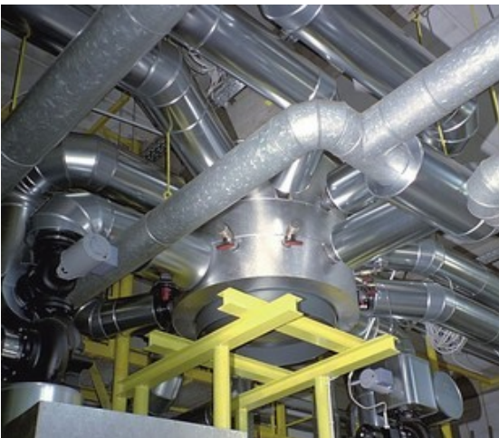
ZORTSTRÖM Multi 2 vrstvy – montáž na pom. konštrukciu nad kotlami priemer 1200mm celkový výkon viac ako 5 MW - Altdorf
