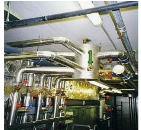
Stropná montáž ZORTSTRÖM Multi - 2 vrstvovej centrály (obr.vľavo) a Multi-U (obr.dolu)
