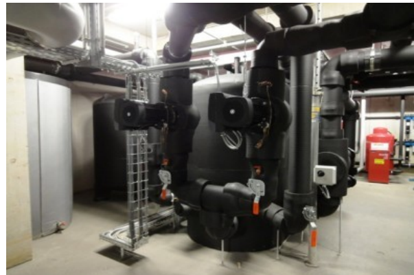
4 centrály Multi 3 stupňové celkový obsah 8000 l
