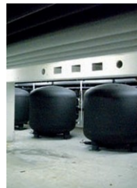
4 centrály Multi 3 stupňové celkový obsah 8000 l
