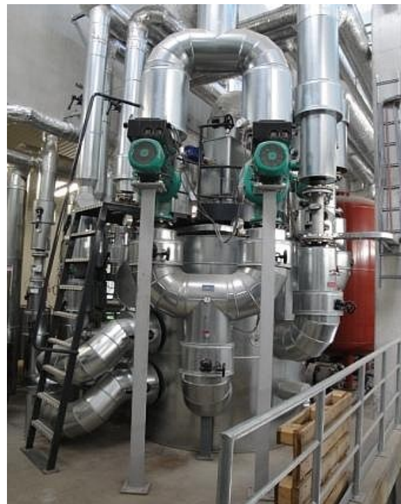
ZORTSTRÖM Multi s 3 vrstvami. Priemer 1800 mm, výška 2200mm, obsah 5160 l, vývody DN80 až DN300 Celkový výkon 11 MW - Bioenergia Wachterbach Na obrázku je vidieť obslužnú plošinu s prístupovým rebríkom a pomoc.konštrukcie.
