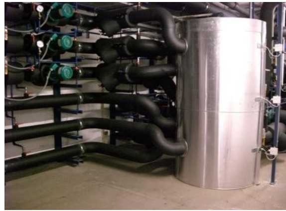
Chladenie 1070kW 3 stupňová Multi centrála
