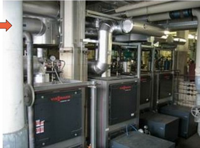
Centrálny zdroj 6 kotlov á 1120kW
