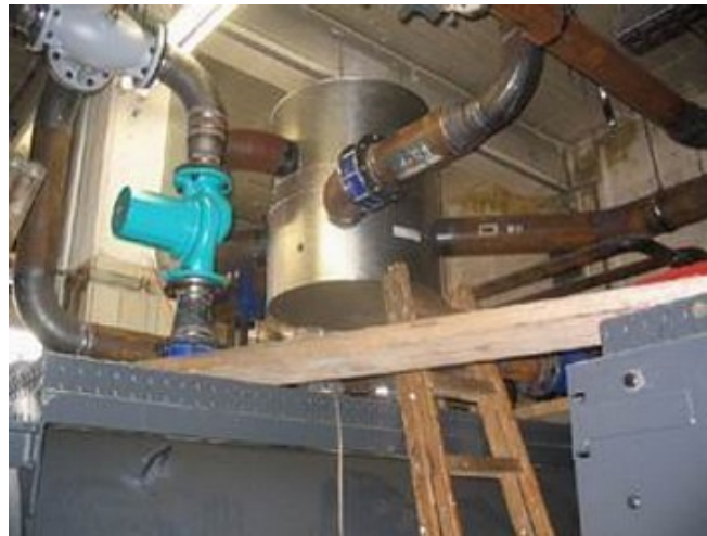
Inštalácia centrály nad kotlami, výkon centrály 6720kW pohľad na fázu montáže
