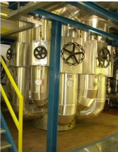
Ďal'kové kúrenie Planseewerke Reutte Skúšané TÜV 13 barov /110°C
