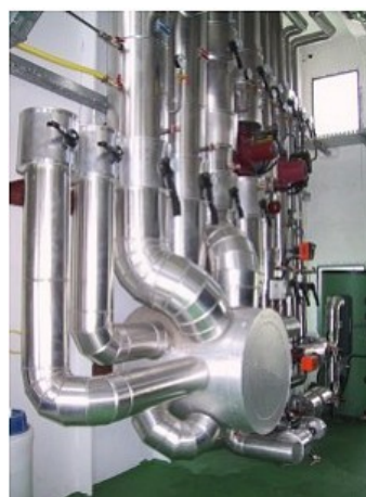
Finálne vyhotovenie už s realizovanou izoláciou
