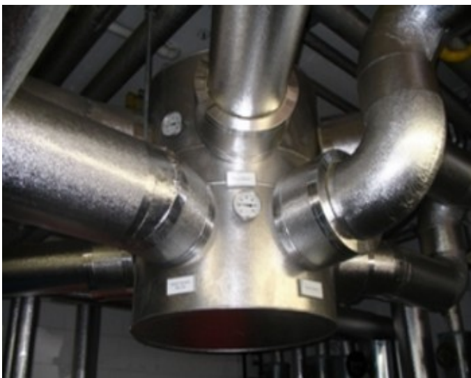
Inštalácia centrály nad kotlami, výkon centrály 6720kW pohľad na fázu montáže
