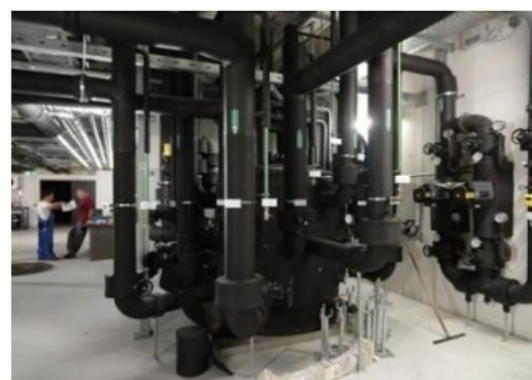
Chladenie 900 kW 4 vrstvá Multi centrála
